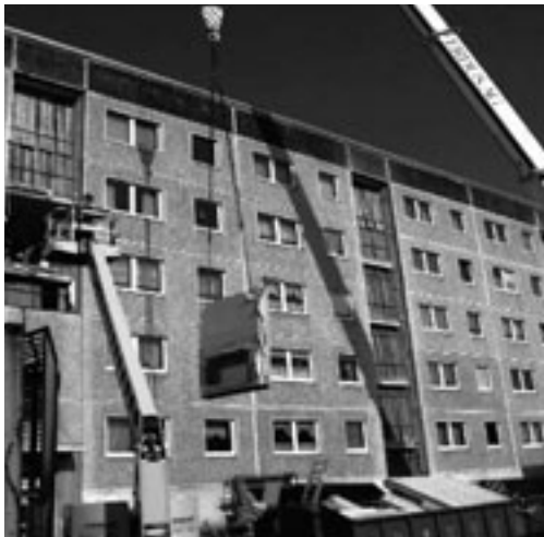
Demontage der Wand im Treppenhaus. Hier entstand der Zugang zum Fahrstuhl.
